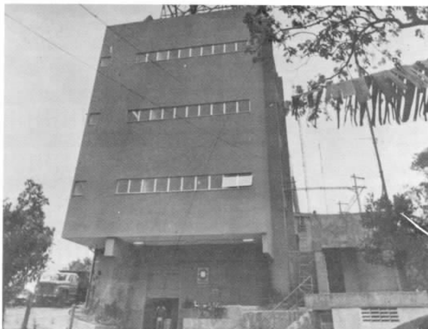
Estação rádio Sumaré: avanço no sistema de transmissão da cidade do Rio de Janeiro.
