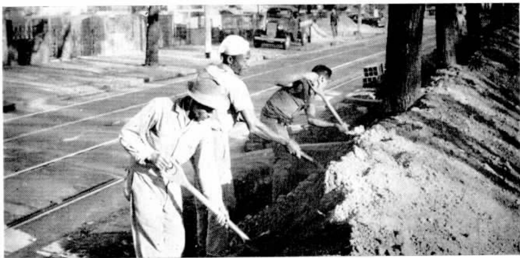
Por toda parte há um intenso ritmo de trabalho: pessoal da CTB trabalha na colocação de dutos.
