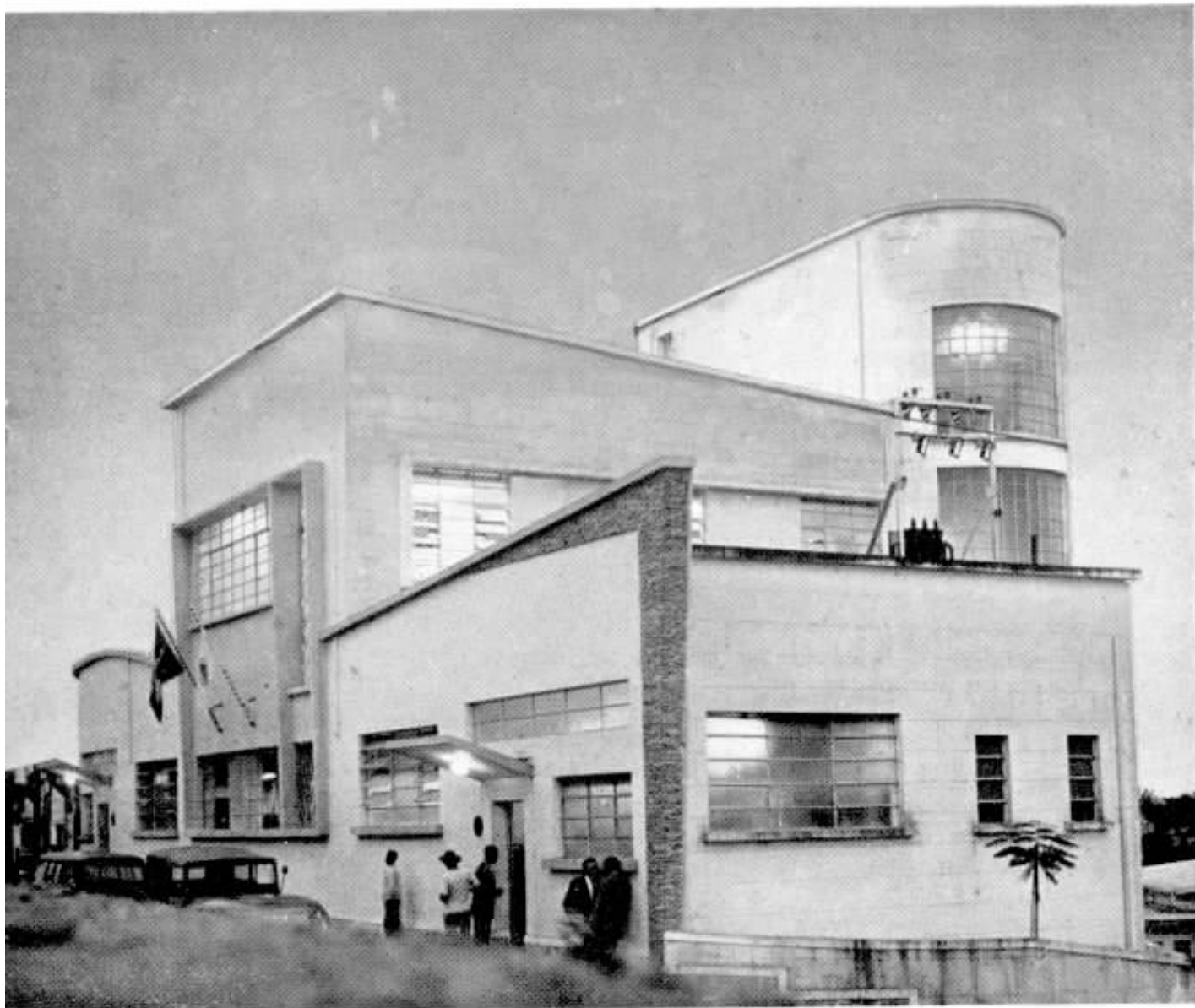
Prédio da nova estação telefônica. Arquitetura moderna e funcional.
