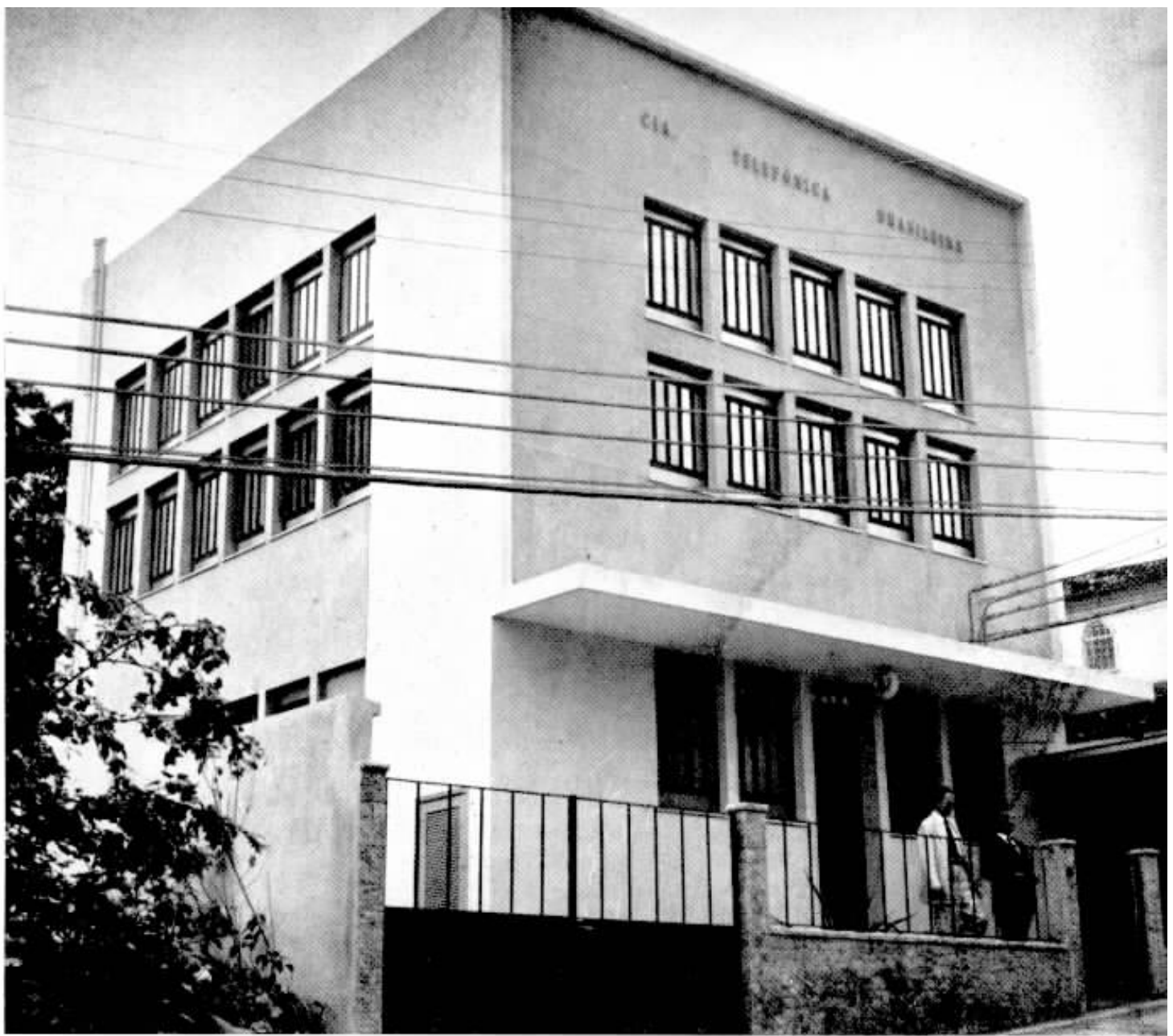
Aspecto do novo edifício erguido pela Companhia Telefônica Brasileira na cidade de Rio Bonito.
