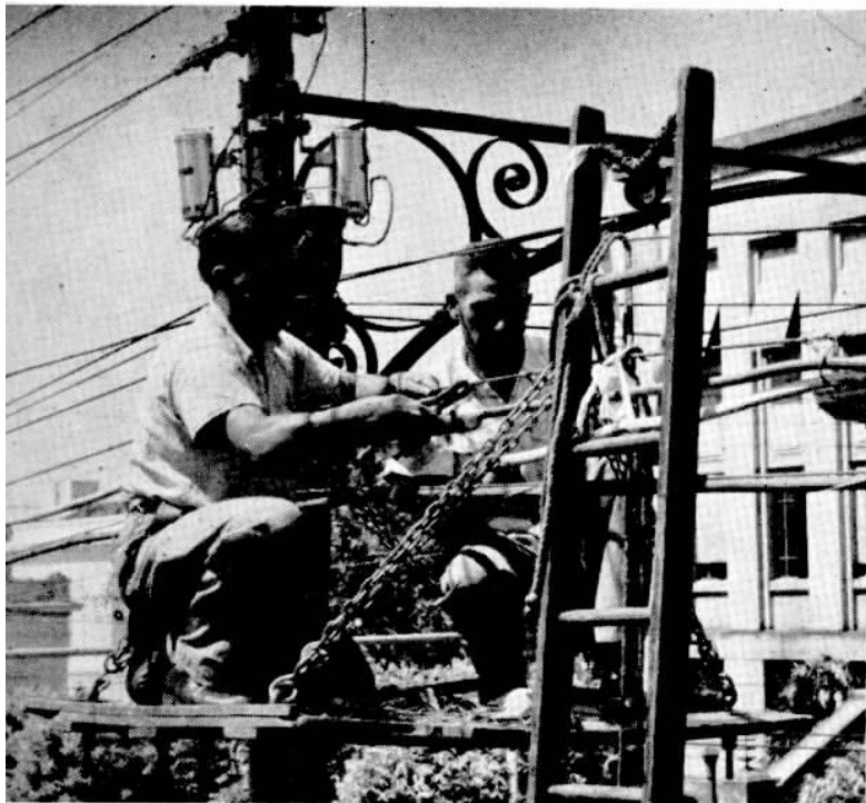
Pedro Zanella, guarda-fios da Rêde e Belmiro de Souza, emendador, êste de São Carlos, completam a emenda de um cabo. Ao fundo o prédio da Prefeitura Municipal.
