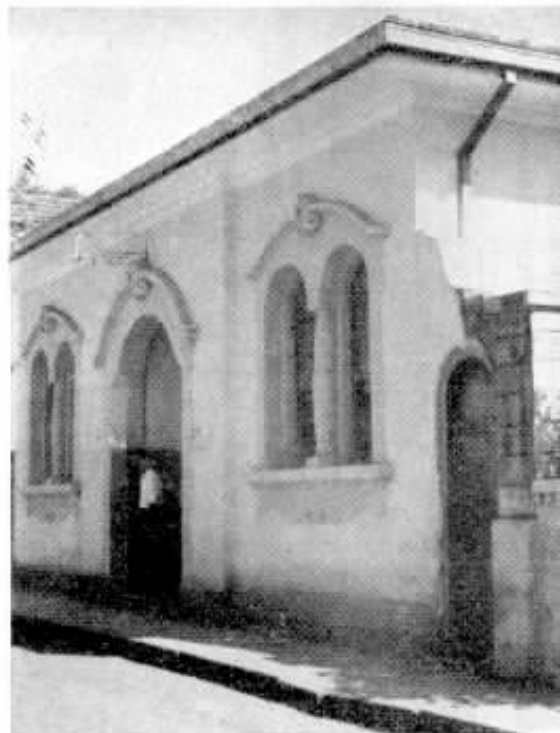
Neste prédio, até o acabamento do bonito e espaçoso edifício, funcionam os serviços da CTMG.
