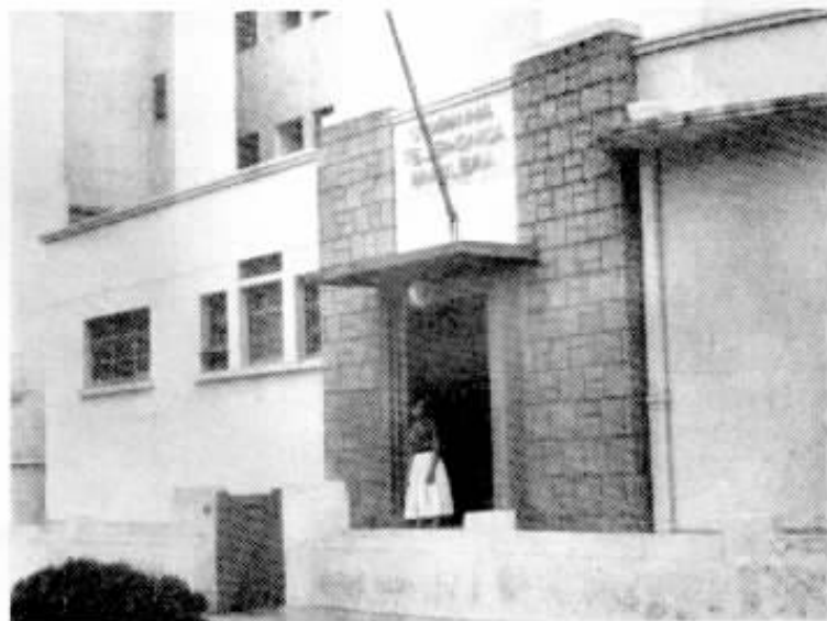
Em Teresópolis, o prédio onde está instalada a Companhia Telefônica Brasileira. Centro de grante atividade e vital na vida da cidade.
