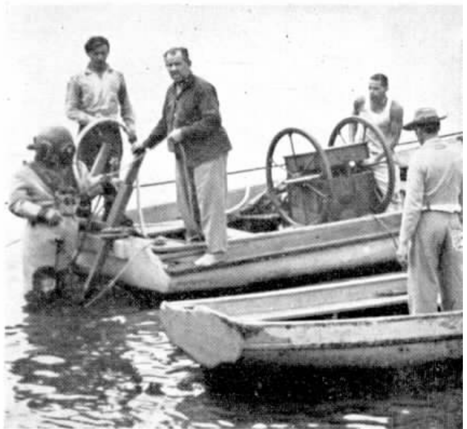
Trabalho dos mais delicados, o lançamento do cabo, exigiu a presença d'um escafandrista. Junto ao Aeroporto, êle desceu para fazer a amarração do cabo submarino. Dêsse ponto, teria início o lançamento.
