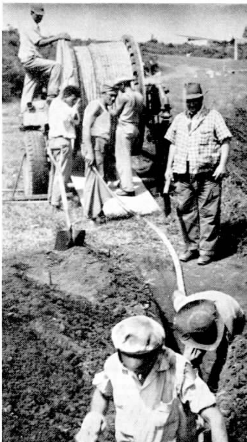
Ainda no trecho da Serra do Mar, vemos mais uma etapa do lançamento do cabo coaxial. Essa turma teve que demover obstáculos para a execução da obra.
