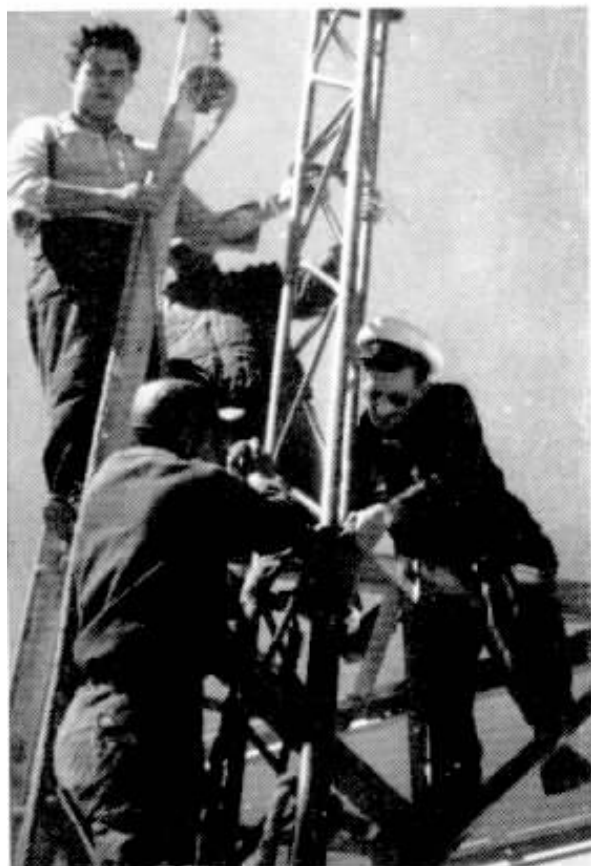
Detalhe da montagem de uma das torres de ensaio de micro ondas.
