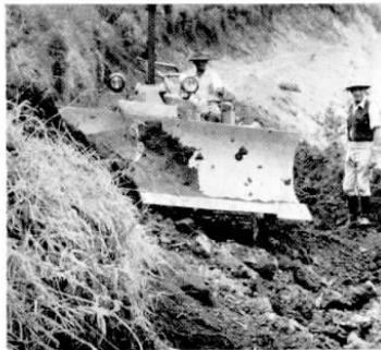
Quando os ensaios comprovaram que os locais eram adequados, foram construídas estradas de acesso ao topo dos morros. Cerca de trinta quilômetros de estradas foram construídos pela C. T. B.
