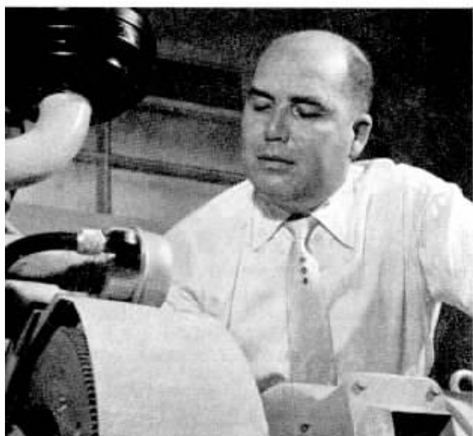
Nagê Pedroso, da Engenharia de Conservação, verifica o gerador de emergência.
