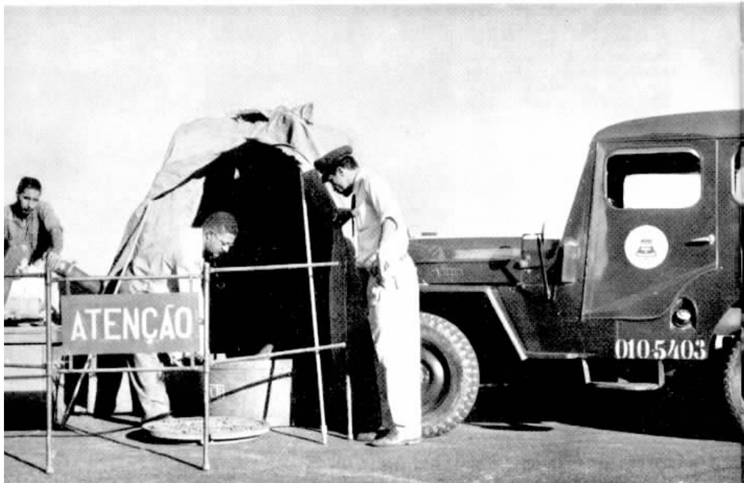
Os funcionários Euclides Ferreira Campos, Wilson Pereira e Cosme Alves, preparando a caixa subterrânea para início de um trabalho de reparo de cabo na cidade caixa.
