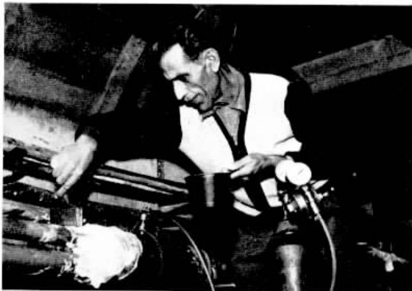
Gervásio L. Macias, após o fechamento da emenda, num teste de segurança com gás nitrogênio, para prevenir contra possível porosidade na superfície soldada.
