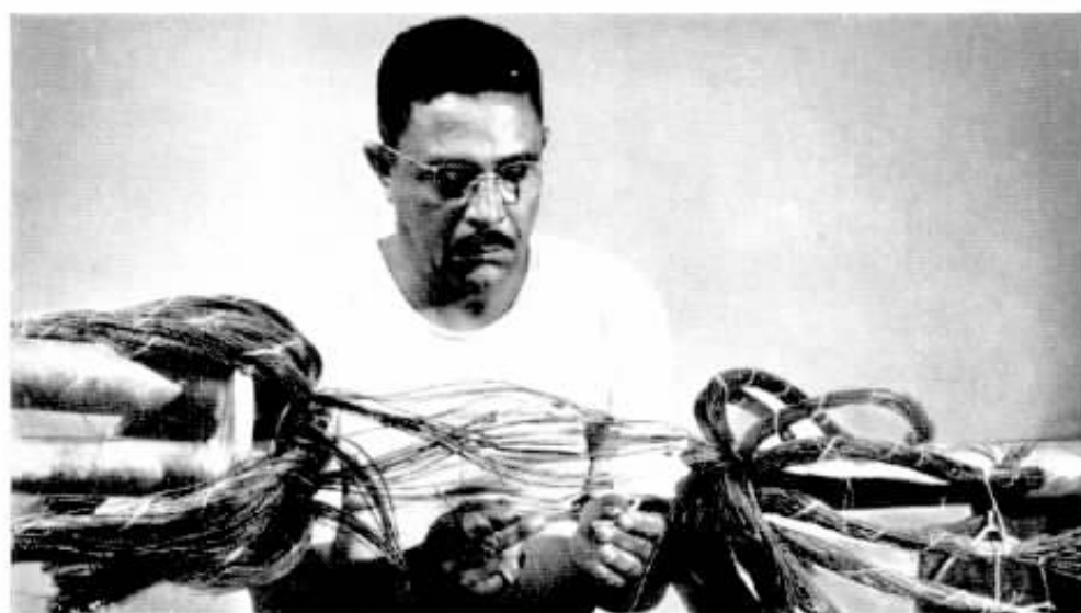
Centenas de pares têm, às vezes, um cabo, que exige do emendador, a fim de evitar interrupções, certo conhecimento. Euclides Campos, na Escola da Rede, está se aperfeiçoando nessa especialidade.
