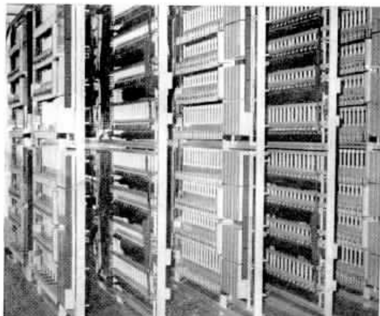
Parte das armações dos 1. os seletores da Estação "Praia".
