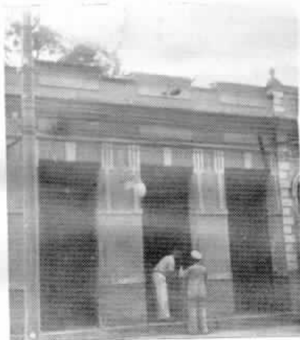
Vista do prédio da Estação Telefônica de Cantagalo.
