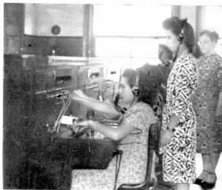
Mesas interurbanas da nova Estação Automática de Resende.
