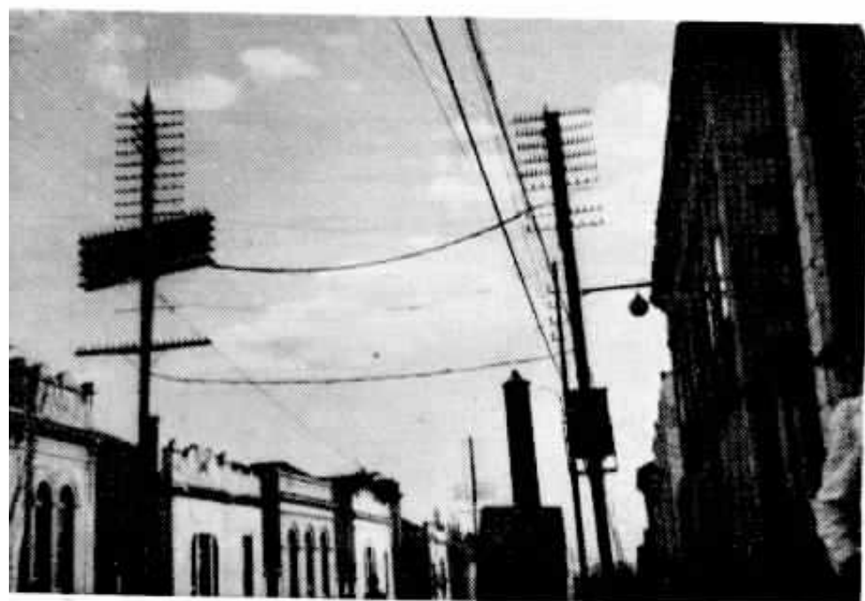
Rua Conde do Pinhal, vendo-se a Estação Telefônica à direita e a antiga posteação e linhas aéreas dos dois lados.
