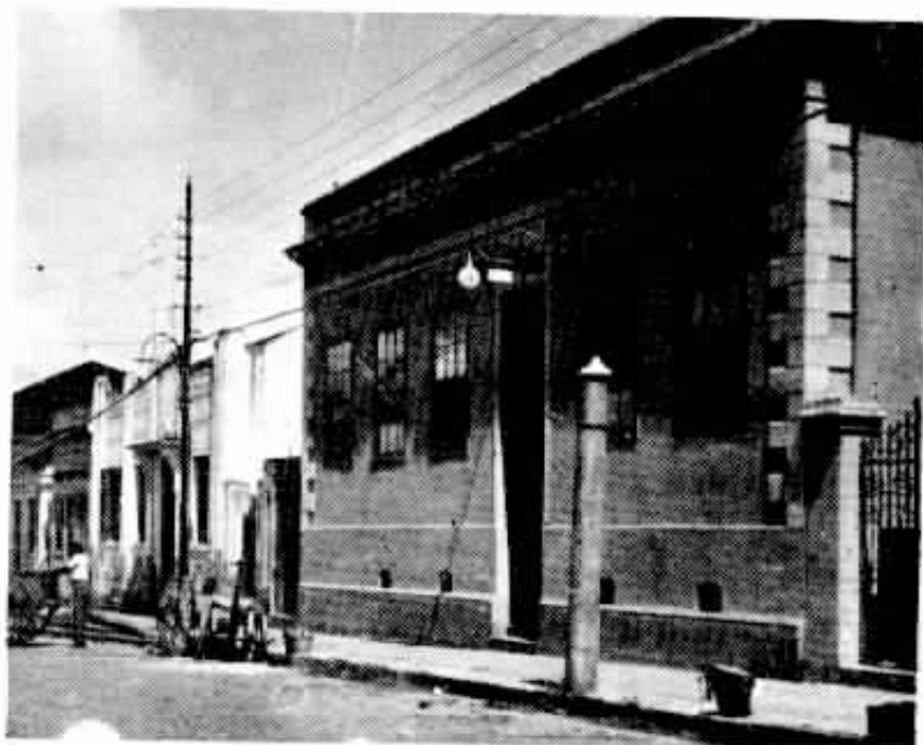
Aspecto tirado depois da substituição, mostrando a Estação Telefônica e o cabo aéreo.
