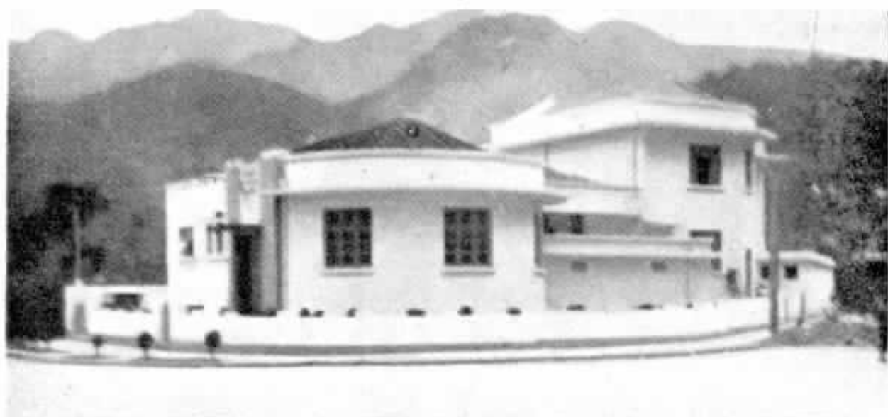
Estação Telefônica de Teresópolis, vista lateral, vendo-se a frente à esquerda
