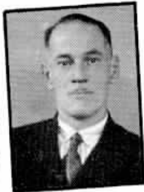
20 anos Virgilio Cantoni Construções S. Paulo
