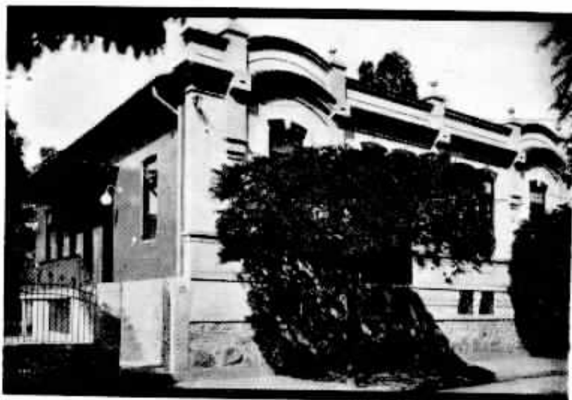
Novo prédio em que funciona a Estação Telefônica de Barra do Pirai.
