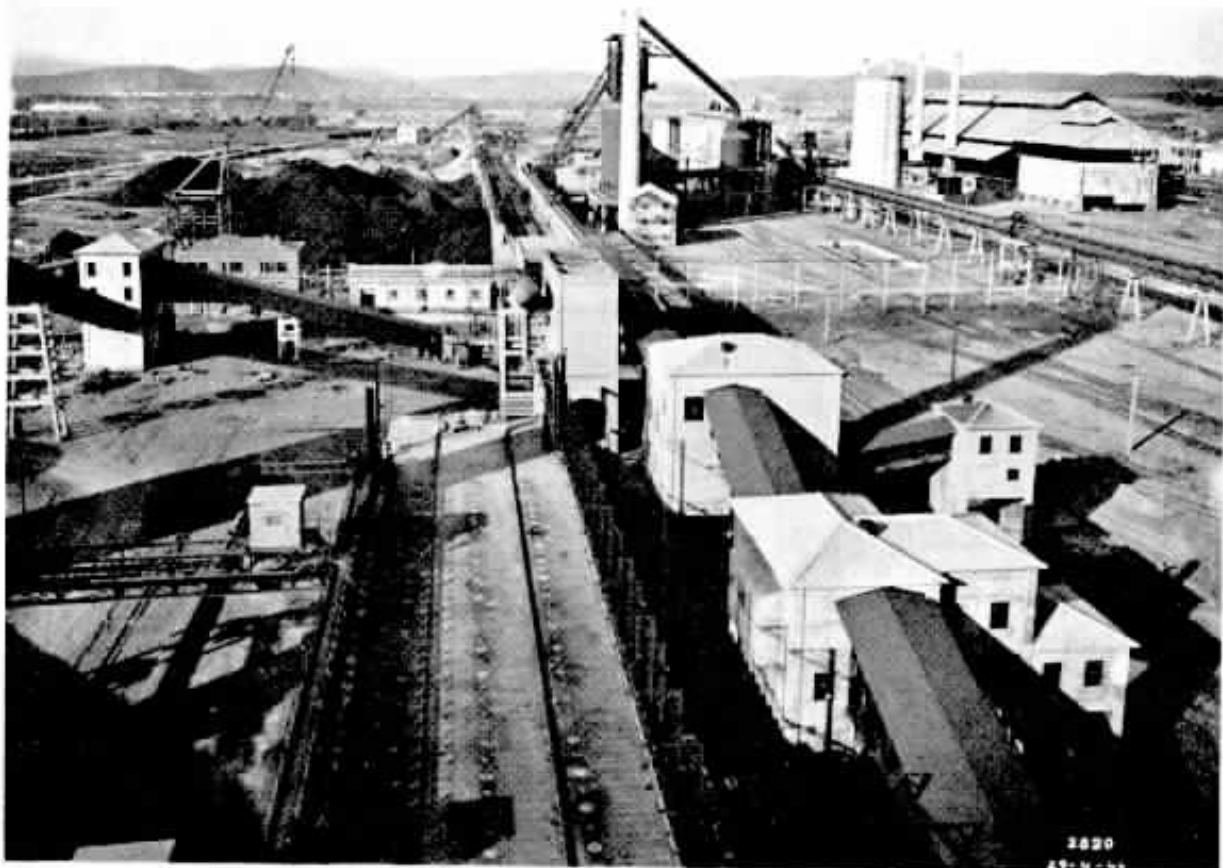
Fotografia mostrando, no primeiro plano, a Bateria dos Fornos de Coque de Volta Redonda
