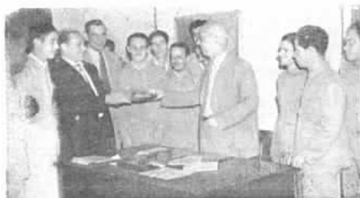
G. Seaton, Superintendente de Instalações, fazendo entrega do "Emblema de Mérito" ao Feitor Moacyr D. Lavogade, sendo assistido pelo Feitor-Chefe Luiz Santarelo F. o , e pelos instaladores componentes dessa turma.
