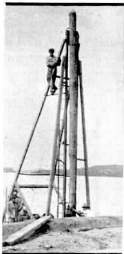
Levantamento da estaca no local do fincamento
