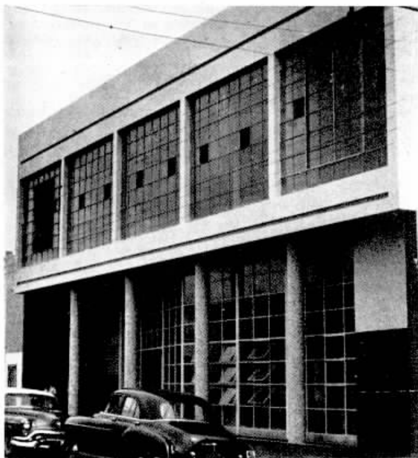
O prédio que será ocupado pela C.T.B. e pela Telefônica de Piracicaba S. A.
