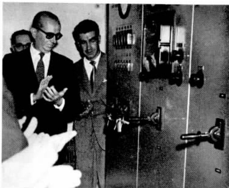
Quadro de força da nova estação, cujas chaves foram ligadas pelo prefeito local, Dr. Savio Gama, pondo em funcionamento o novo serviço telefônico
