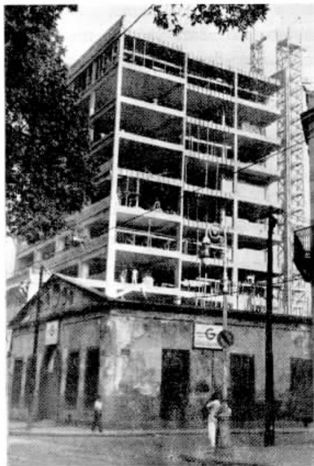
Vista da estrutura de cimento armado, parte dos fundos, do novo prédio da Companhia Telefônica Brasileira, em construção
