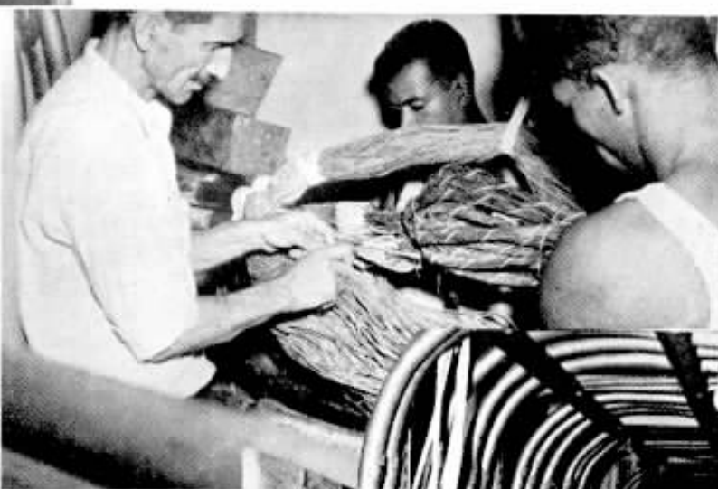
Na estação "26-46", o Emendador Benedito Coelho procede a emenda de um cabo atingido pela enchente
