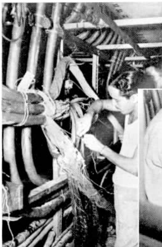
Na estação "26-46", o Emendador Benedito Coelho procede a emenda de um cabo atingido pela enchente
