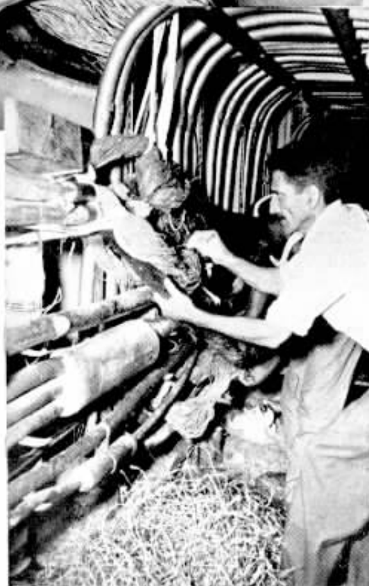
Na estação "26-46", o Emendador Benedito Coelho procede a emenda de um cabo atingido pela enchente
