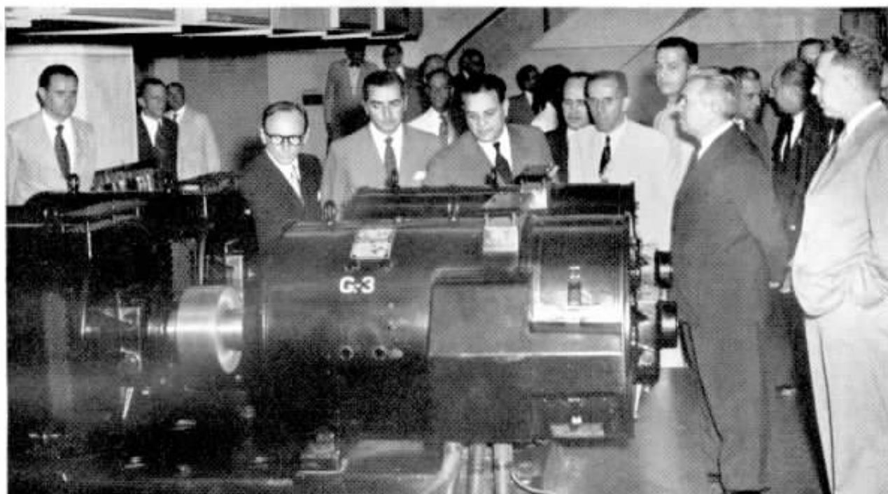
O Prefeito Alim Pedro examinando a casa de máquinas da nova Estação
