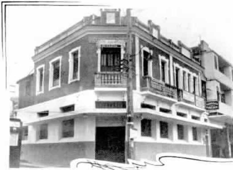
Prédio onde funciona o Posto Público Interurbano em Cachoeiro do Itapemirim, na rua Jerônimo Monteiro n. 14
