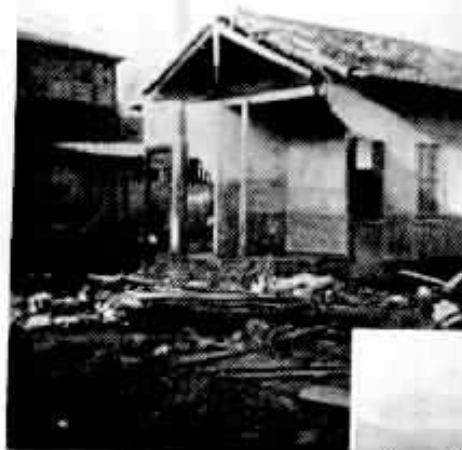
Pirapetinga, em outro aspecto dos danos que a enchente causou à cidade
