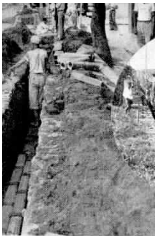
Início da construção da linha de dutos na rua Ibitiúva, em Moça Bonita
