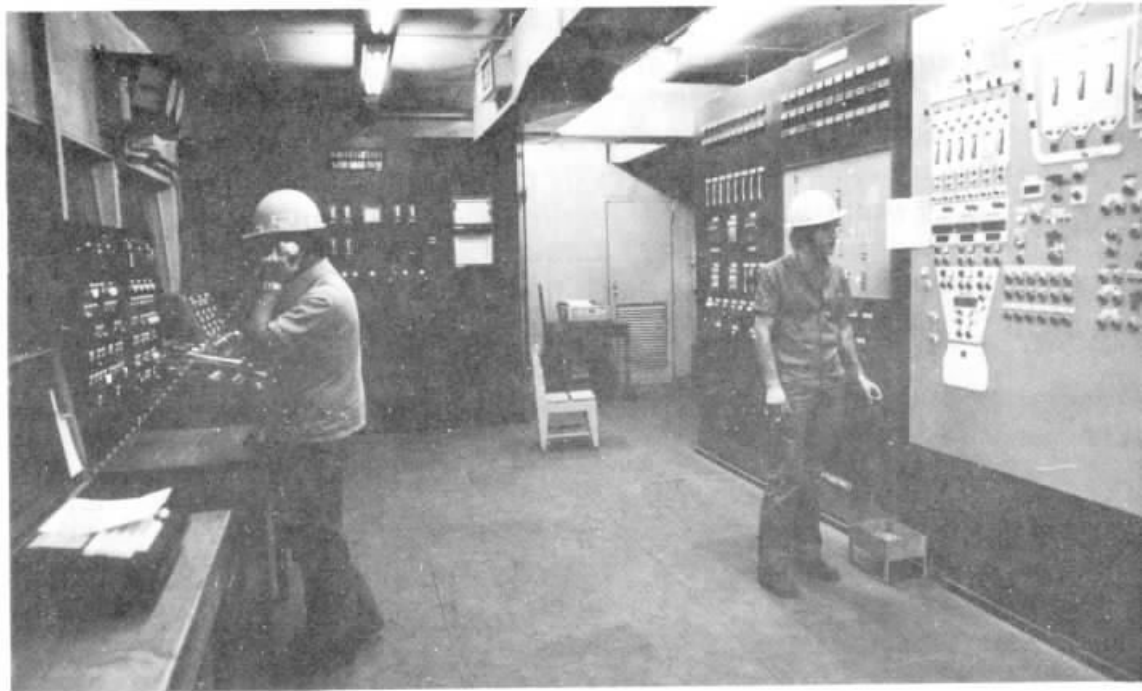
Na aciaria, tudo sob controle.
