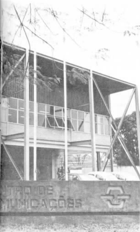
O novo Centro de Comunicações abriga uma potente central telefônica.
