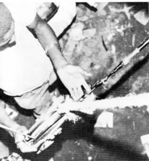
Primeira etapa do entroncamento no Rio: 25 quilômetros de Ipanema à Alvorada.
