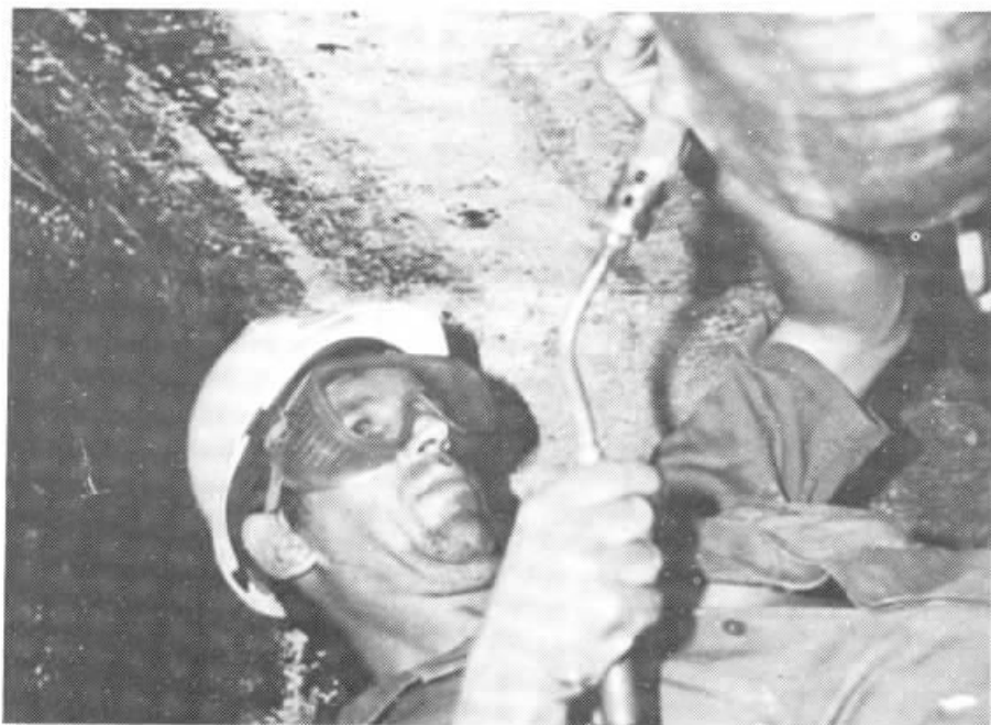
O trabalho realizado na rede subterrânea contribuiu para a melhoria do sistema.
