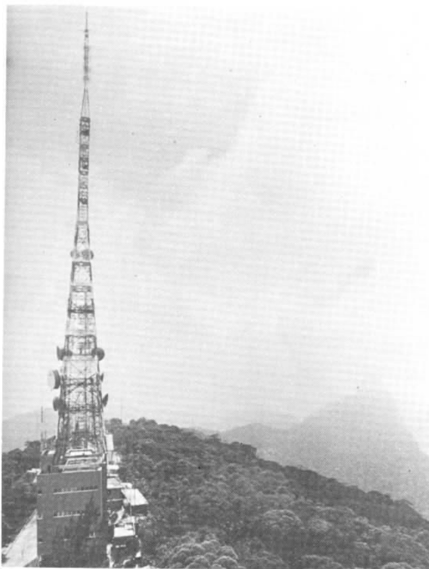
Estação Rádio Sumaré: um importante avanço nos sistemas de transmissão.
