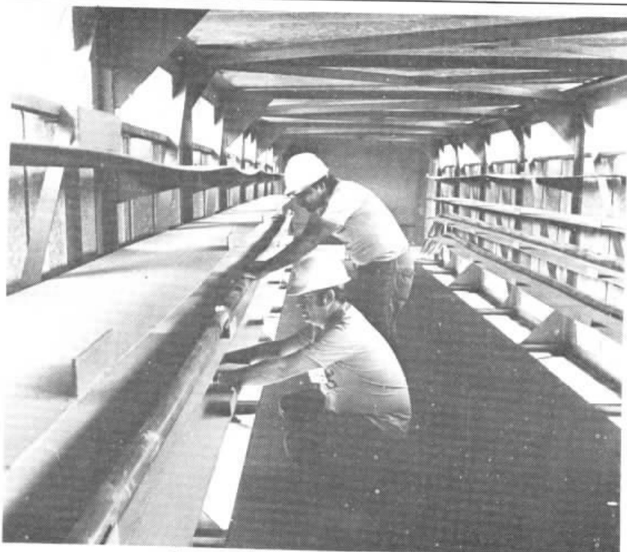
Muitos cabos foram remanejados em canteiros de obras do metrô.
