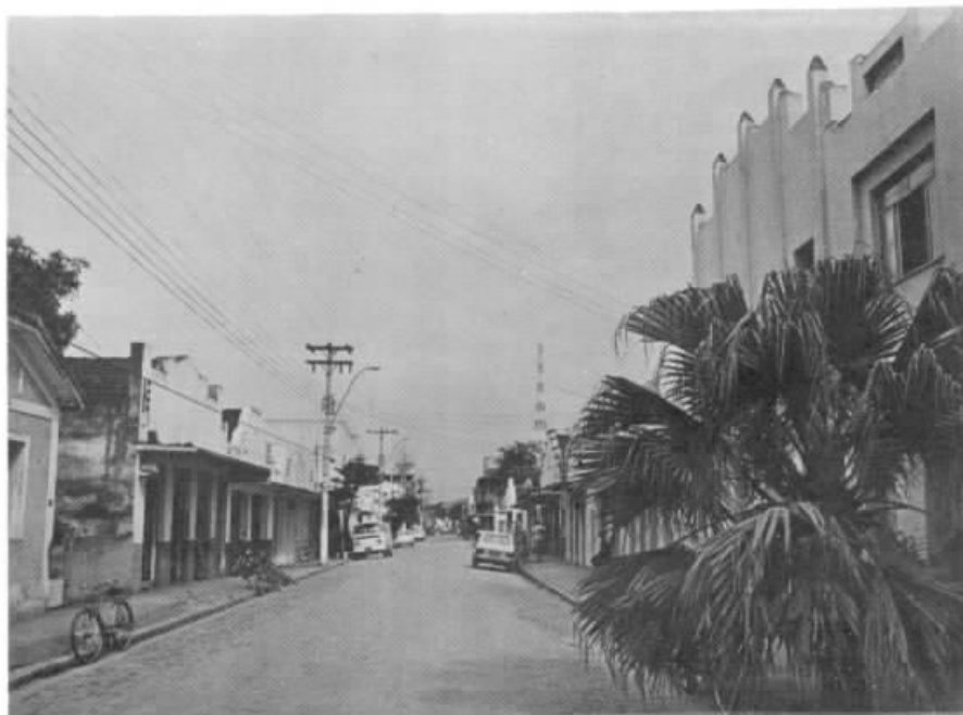
Italva, o mais novo município do Estado, já dispõe de telefonia automática.
