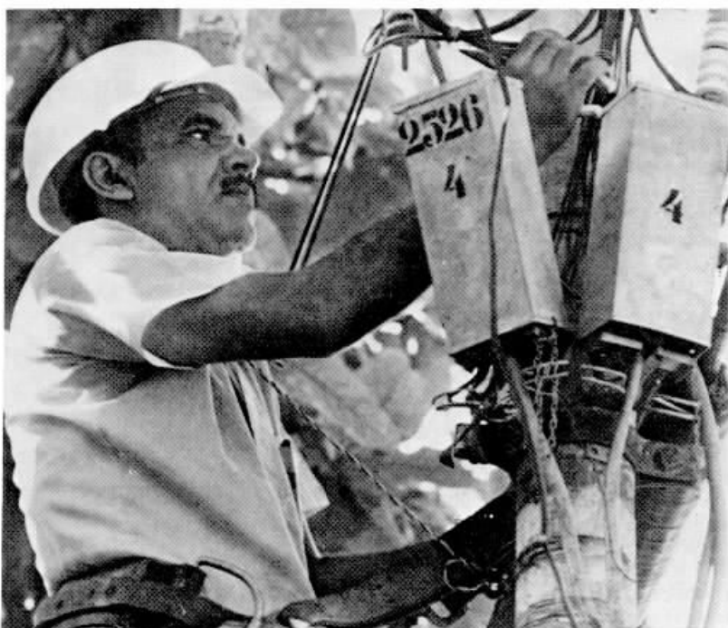
Escada, capacete e cinto de segurança são indispensáveis ao exame das condições da rede aérea
