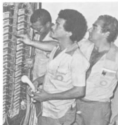
O novo sistema do Maracanã possui um cabo com 800 pares.
