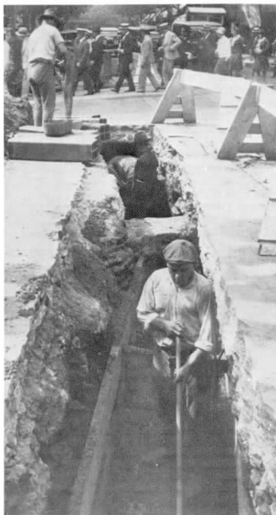
Empregados preparam terreno para instalação de cabos telefônicos. Ano 1929.
