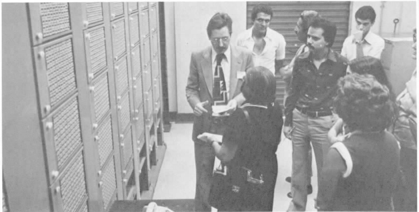
Nas visitas às estações telefônicas, os assinantes verificam como funcionam os contadores de impulsos e recebem várias explicações teóricas e práticas.
