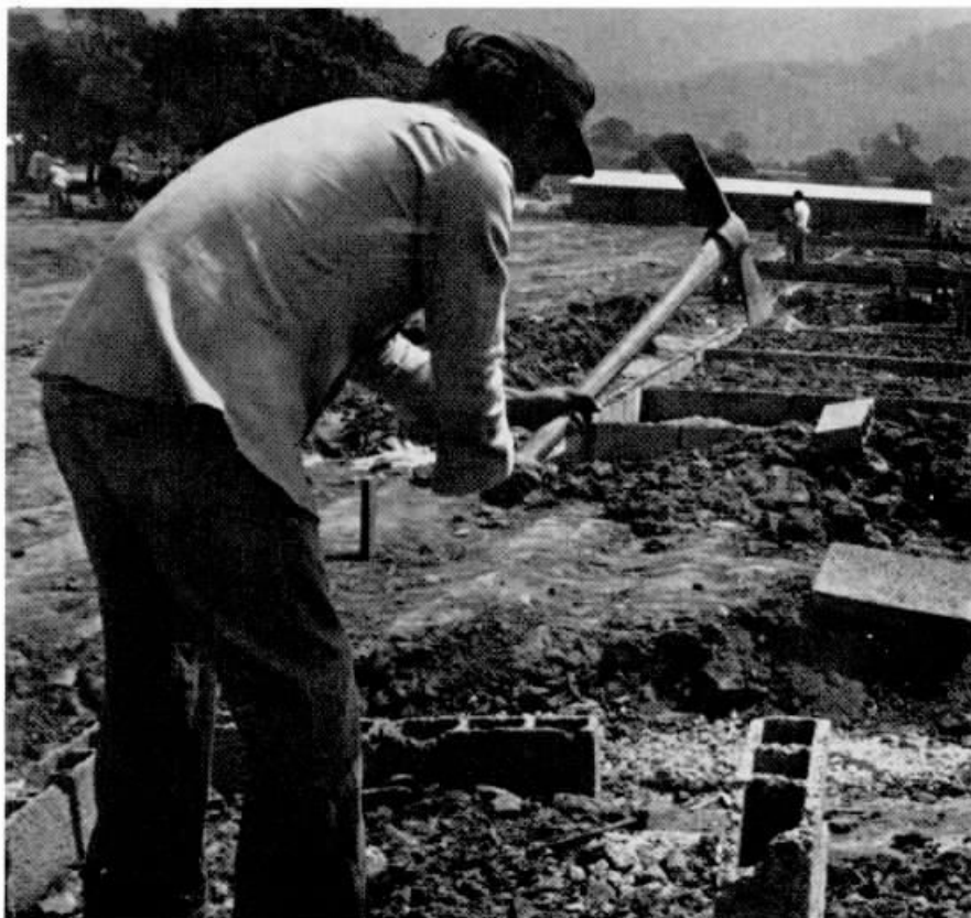
No Conjunto de Quafá, em Bangu, já começou a construção de 508 casas para os empregados da Telerj.
