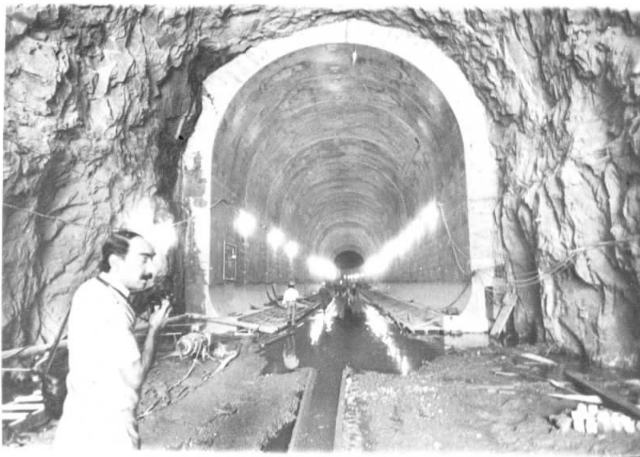
Através do túnel de 1 km de extensão, escavado na rocha, a água de refrigeração será lançada ao mar.
