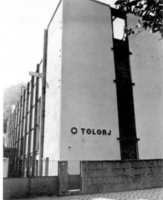
No prédio da nova estação. . .
