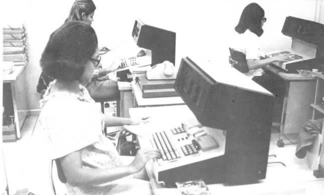
Através das digitadoras, as informações são gravadas em fita cassete.
