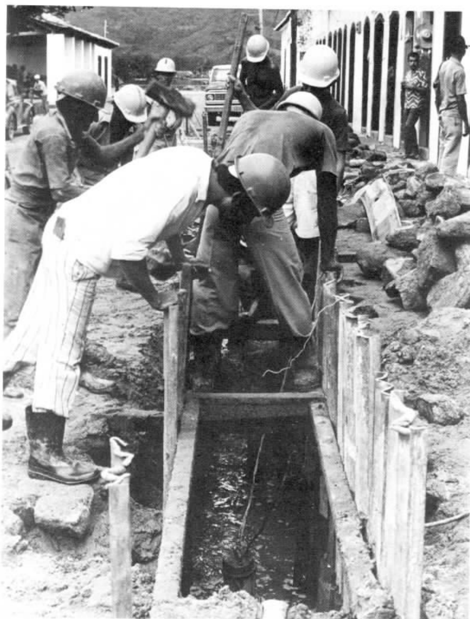
A construção das galerias subterrâneas exige cuidados especiais.
