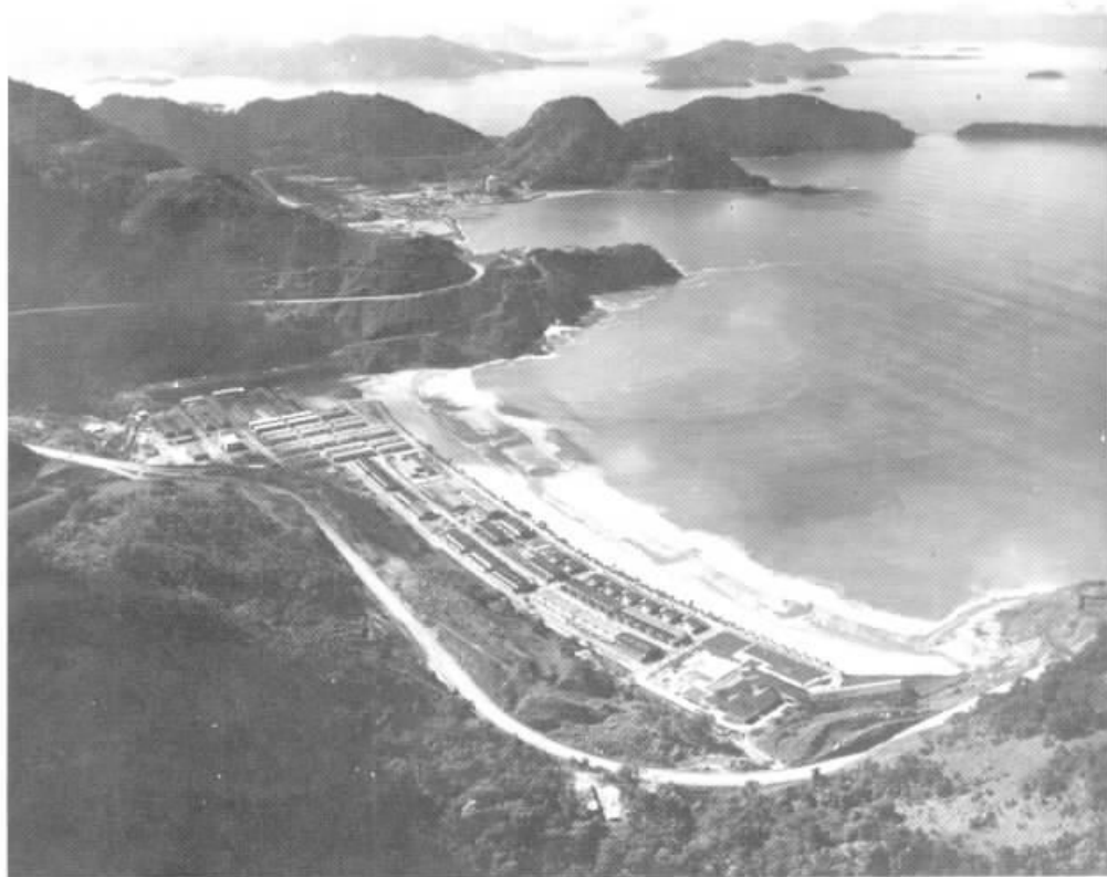
A vila residencial de Praia Brava fica a 3 km da Central Nuclear.
