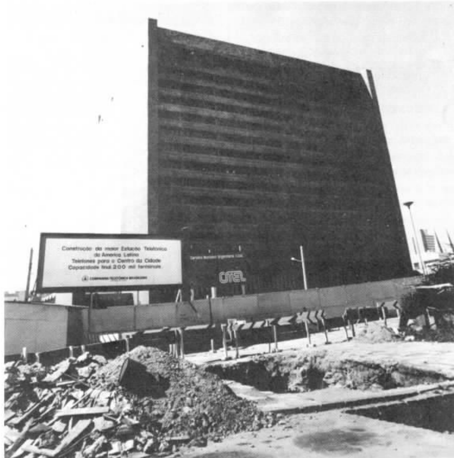
Quase concluída, a Estação Arcos terá capacidade para 200 mil terminais.
