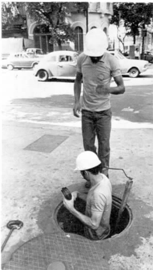
Alertados do vazamento, os técnicos descem à galeria e medem a pressão dos cabos com o manômetro.
