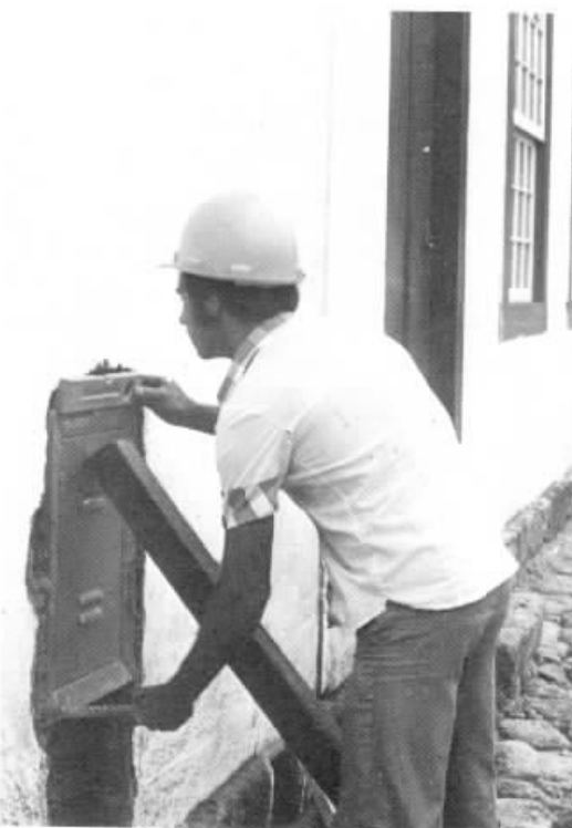
Espessas paredes abrigam terminais.
