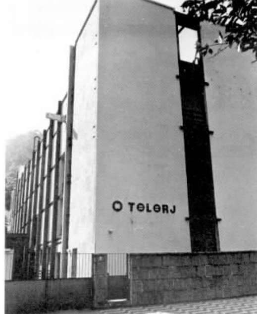
No prédio da nova estação. . .
