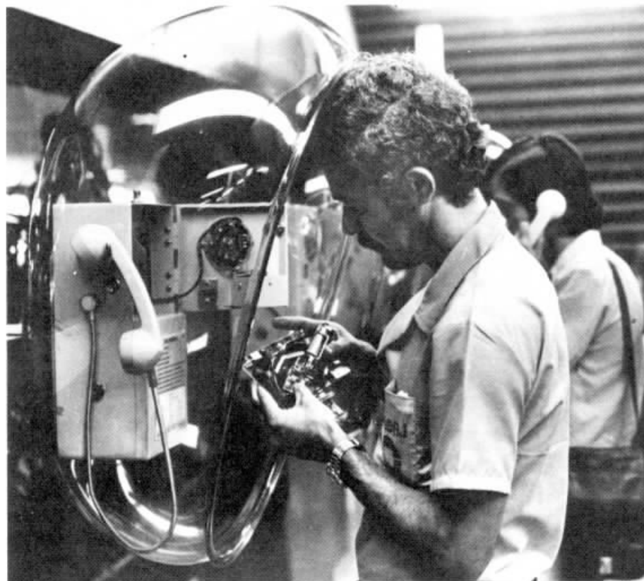
Após a vistoria, substituição de peças.
