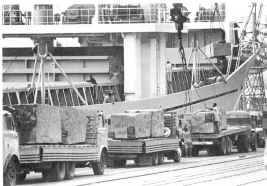
Extensa maquinaria auxilia o sistema de carga e descarga dos produtos.
