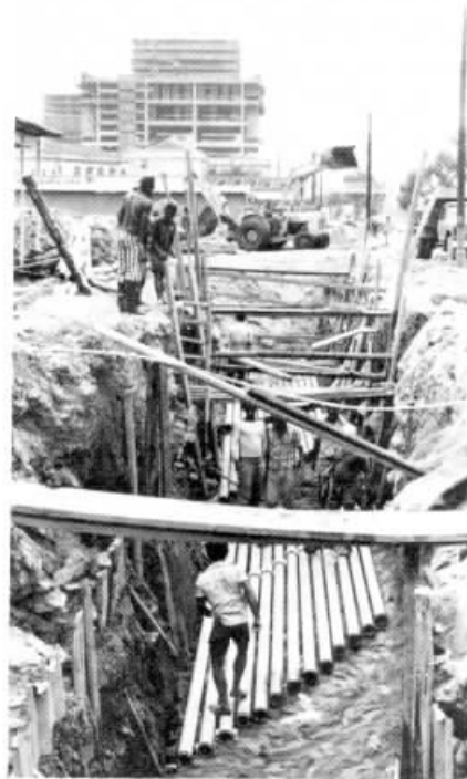
Colocação de ductos: ritmo acelerado.
