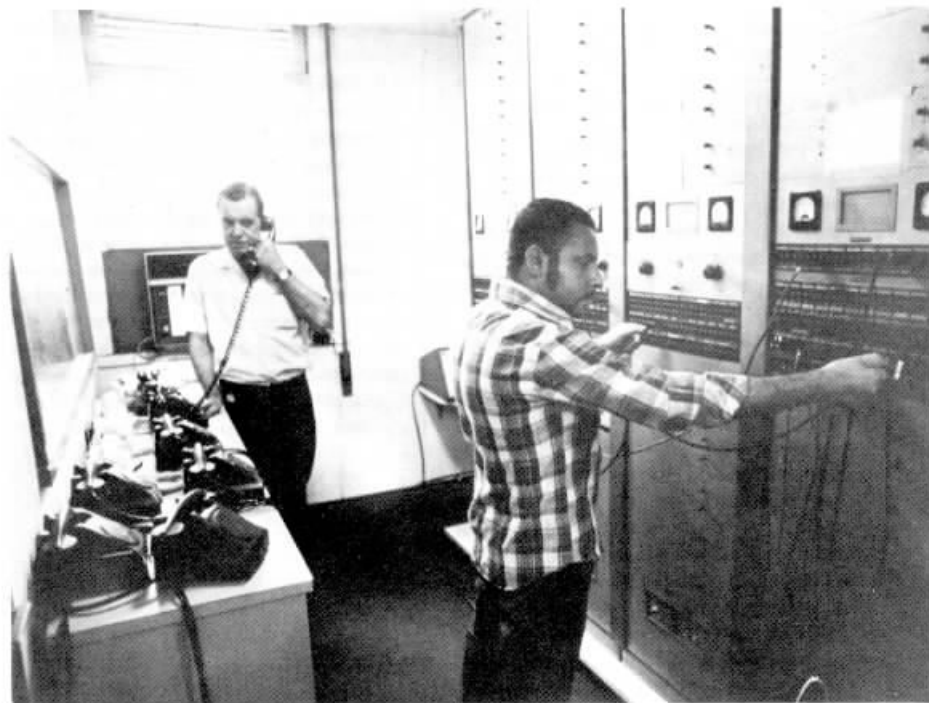
O equipamento multiplex está ligado, por LPs, às estações de rádio e TV do Rio.
