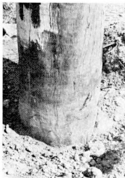
Este poste, no interior de São Paulo, tem sua base em perfeito estado após 36 anos de serviço
