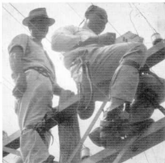
Guarda-fios de Itu removem um defeito do importantíssimo tronco interurbano Sorocaba-Campinas.
