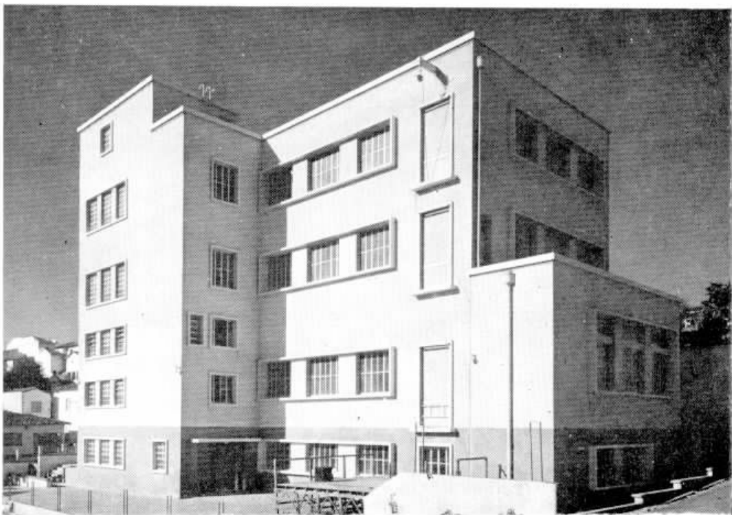
Acima, o prédio da estação "61", Santo Amaro, visto dos fundos, com o espaço vago de terreno para a futura ampliação destinada às novas centrais telefônicas do bairro. Abaixo, a estação "65" de Perdizes, onde está programada a ampliação de sete mil e cem novos terminais.
