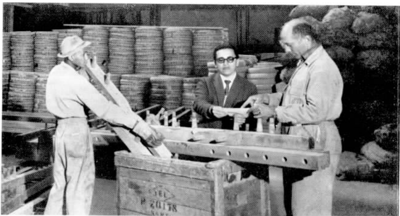
José Alves Barreto, Encarregado Geral, ao centro, responde pelo almoxarifado central de São Paulo, tarefa das mais complexas, dado o grande volume de materiais ali depositados e em constante requisição para os mais variados empregos, em múltiplos lugares onde se faz notar a esfera da CTB.
