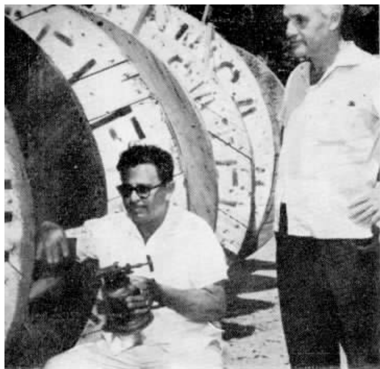
Martins Cardoso e João Luciano de Souza, este encarregado de Depósito de Materiais e Ferramentas da Seção de Construções, em plena atividade diária.
