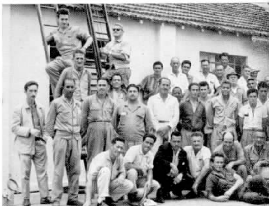
A instalação em curto prazo de cinco mil telefones em Campinas, obrigando a colocar cem aparelhos por dia, em dois meses apenas, numa expansão magnífica, levou a CTB a um verdadeiro "mutirão" na Rede. Instaladores de diversas origens, como da Guanabara, Estado do Rio e de
