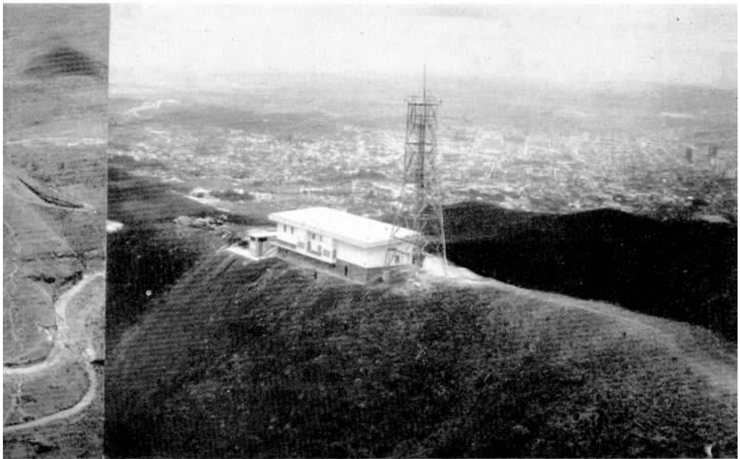
A mesma torre vista de outro ângulo, em fase final de construção. Todos os esforços estão sendo empregados para a pronta inauguração das micro-ondas.
