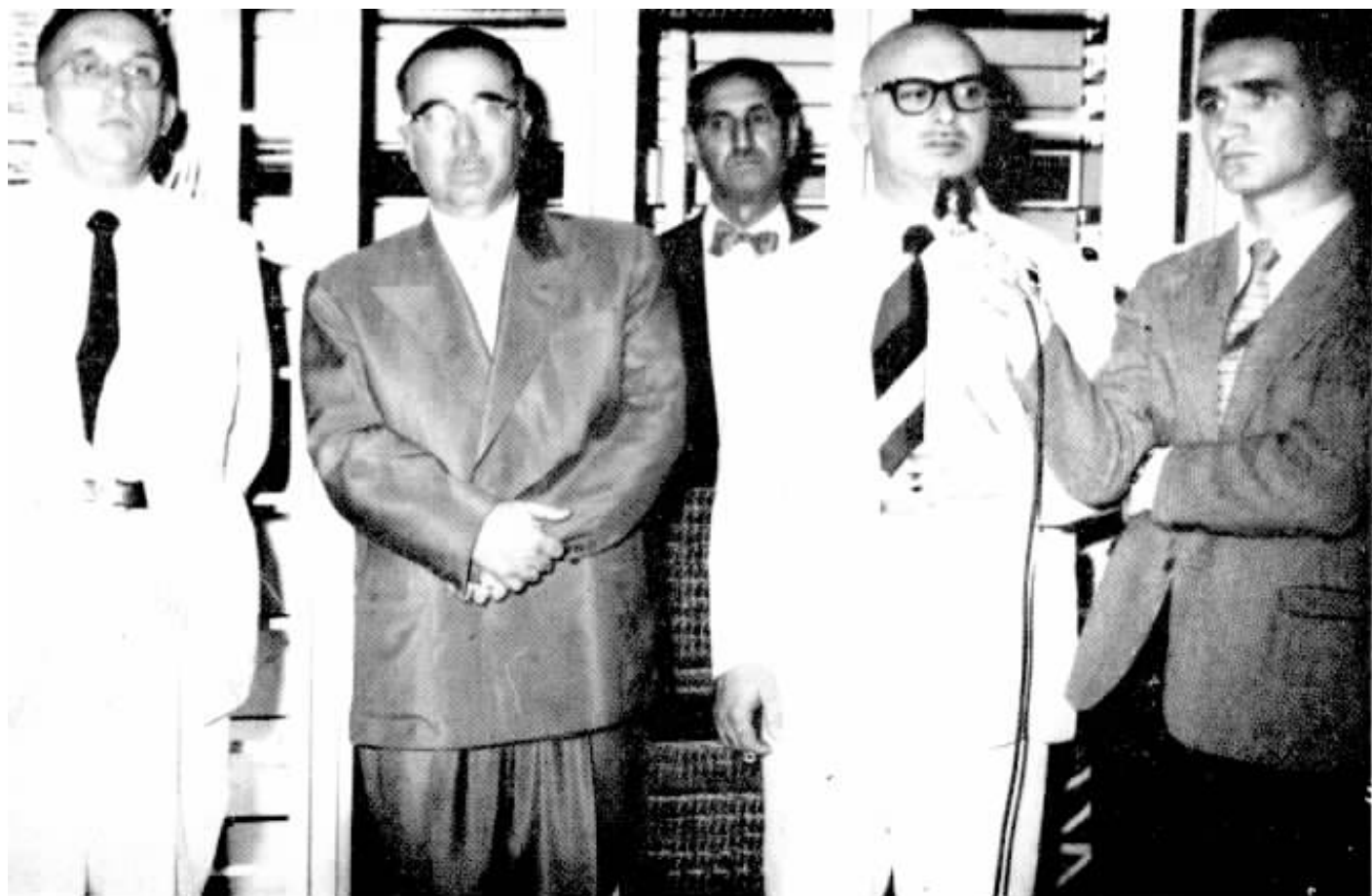
No ato inaugural da estação automática falou o Presidente da Câmara Municipal, Dr. Pedro Marão, que destacou a importância do ato para o progresso da bela cidade interiorana.
