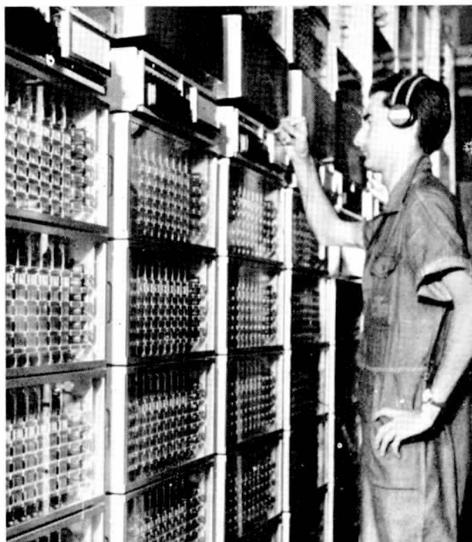
A inauguração do serviço automático, tirou de funcionamento a estação de magneto com capacidade de 830 linhas.
