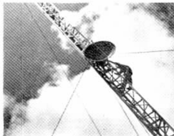
Colocação da antena no lugar. Trabalho preliminar dos exames de propagação.
