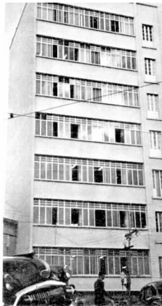
O novo prédio onde está localizada a Administração da C.T.M.G.
