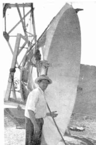
Disco refletor parabólico, equipado com pala de blindagem de duralumínio, içado para ser colocado no alto da torre.
