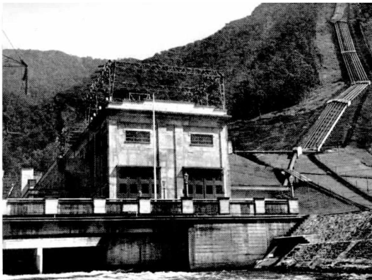
Vista do conjunto das usinas de Cubatão
