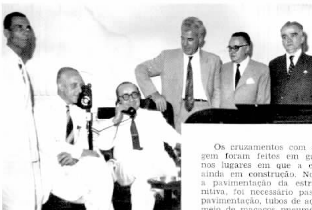
Primeira ligação para Niterói, pelo cabo coaxial, atendida pelo Doutor Salo Brand, Secretário de Viação e Obras
