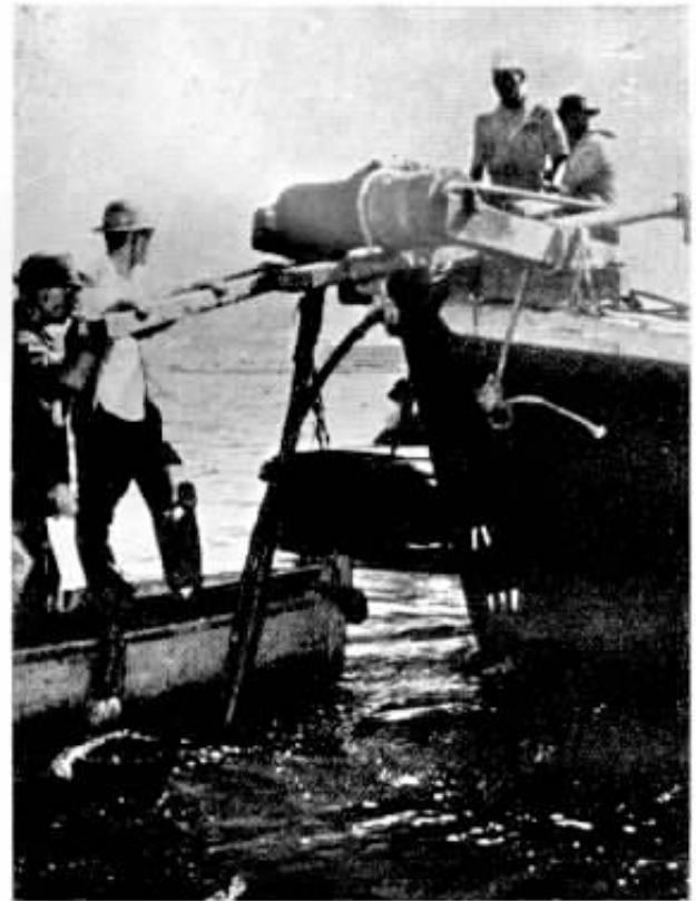
O cabo n. 1 sendo içado para localizar o defeito
