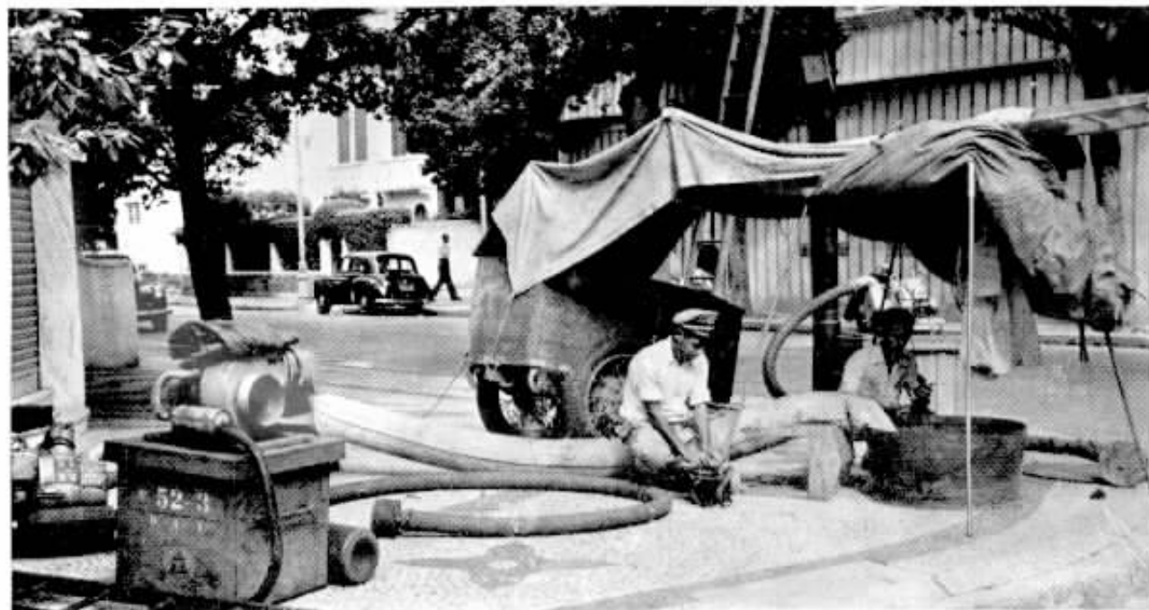
Em Copacabana procede-se à transferência de um cabo subterrâneo
