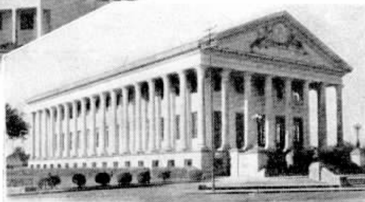
Edifícios da Santa Casa e do Forum
