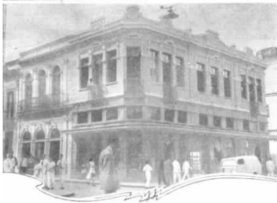
Prédio da rua da Alfândega esquina da rua Jerônimo Monteiro, em cujo sobrado está instalado o Posto Público Interurbano de Vitória.
