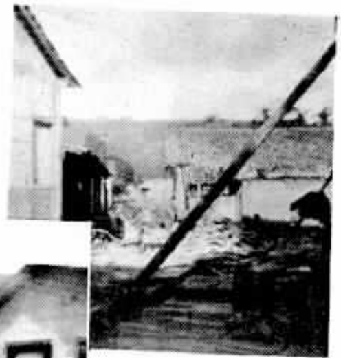
Pirapetinga, num aspecto mostrando os estragos causados pela enchente
