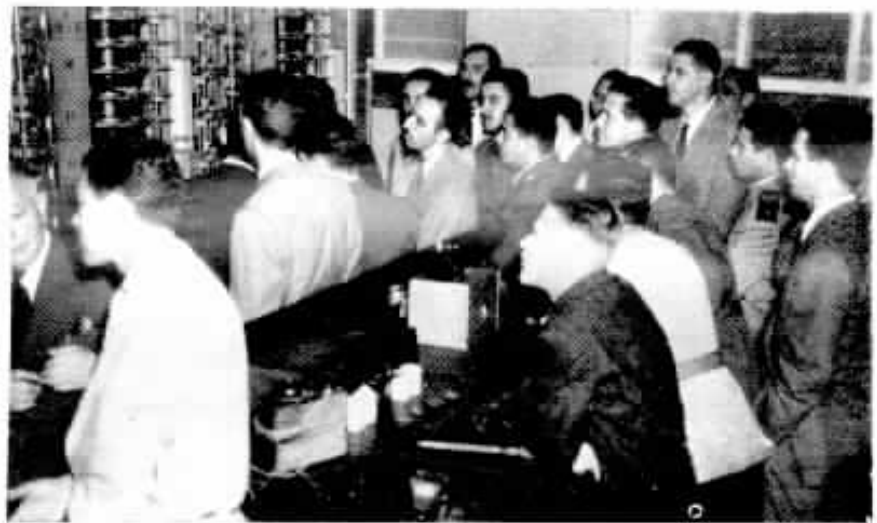
Flagrante feito junto ao Distribuidor Geral das Estações "26" - "46", quando era explicado o seu funcionamento.
