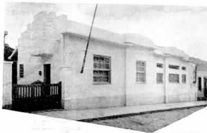
Prédio próprio onde funciona a nova estação telefônica de Vassouras.
