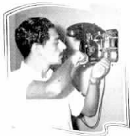
Curso de Instaladores. Instalação de aparelho de parede
