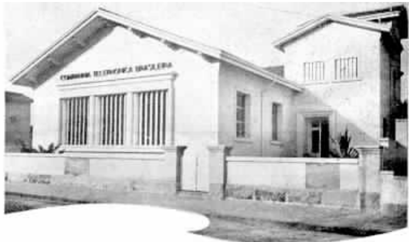
Prédio da Estação "Praia", de estilo residencial, acompanhando as construções que o cercam.
