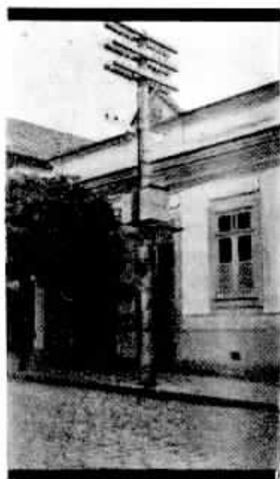
Vista do poste de entrada das linhas interurbanas na nova estação.
