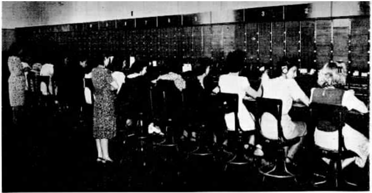
Fotografia tirada na sala de ligações do Centro Telefônico de Bauru, onde foram inauguradas as 7 novas posições, vendo-se as 16 posições interurbanas atualmente funcionando naquele Centro Fiscalizador do Distrito.
