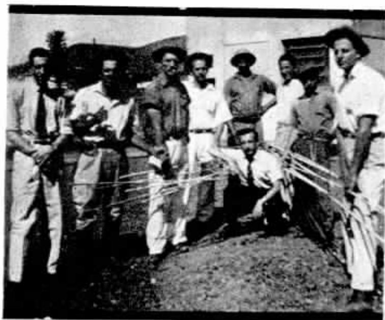
Turma que executou o serviço, vendo-se a ferragem do poste.
