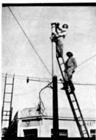
O poste novo depois de colocado.
