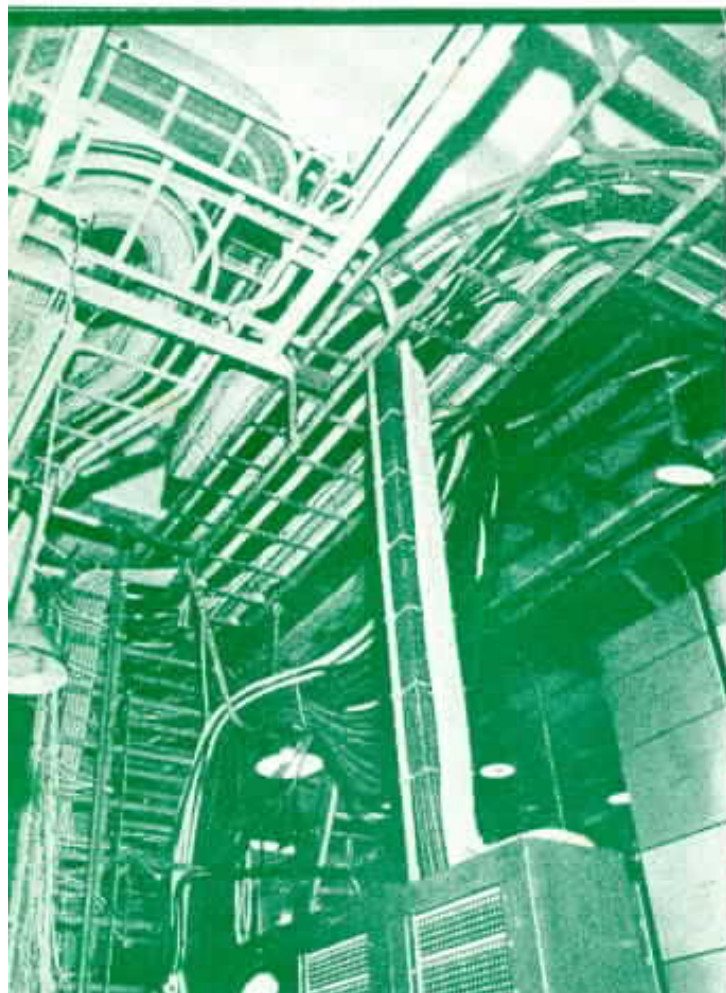
Em baixo, vista da descida dos cabos, vendo-se amarrados com jumper os cabos após a inauguração.
