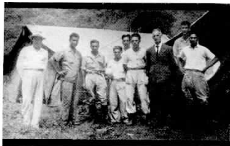
Celestino Romeu e a Turma de Construções da Linha-Tronco Santos-Bertioga.
