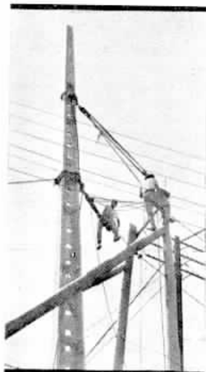
Fase final do levantamento de um poste de concreto armado, tipo "Cavan", em Osasco, ao serem retirados os moitões.
