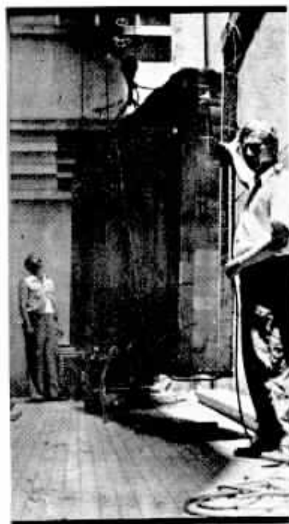
Vista da caixa já presa ao guincho e pronta para ser levantada.
