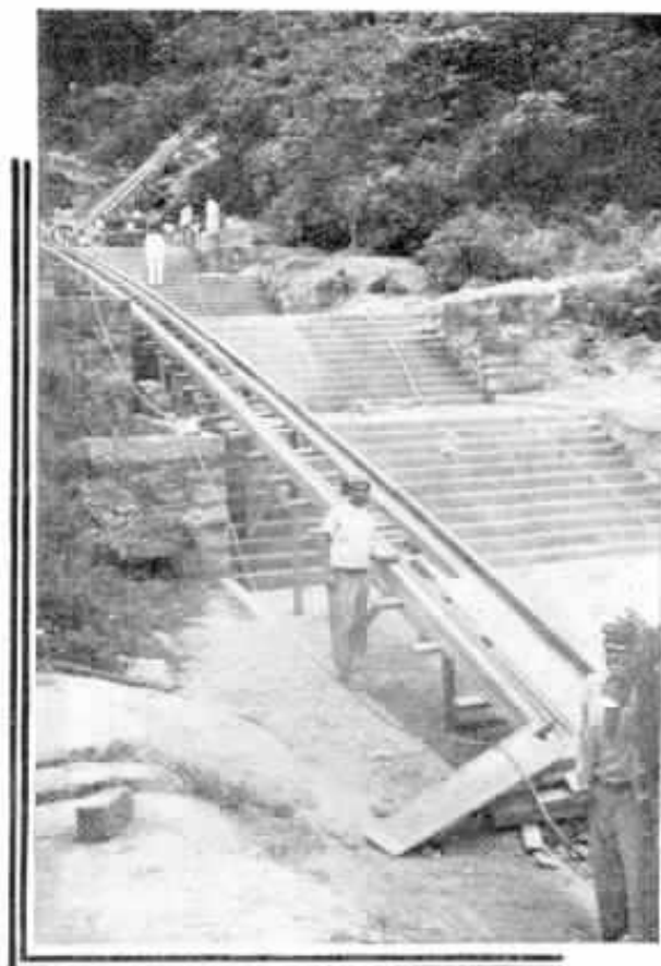
Vista apanhada da rua Marechal Francisco Moura, vendo-se a escadaria desta e a disposição do plano inclinado para elevação do material.
