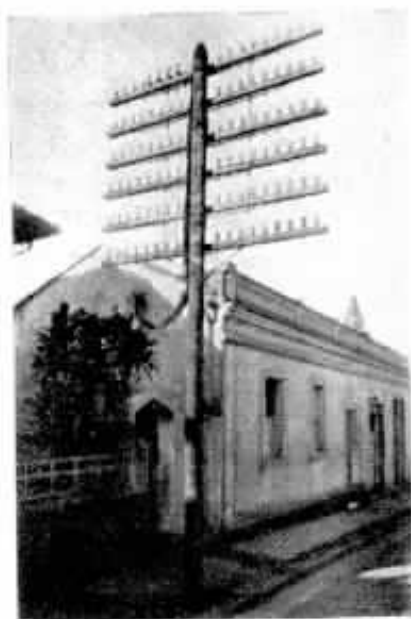
Aspecto da sede antiga e do prédio onde funcionou a estação telefônica até 19 de Junho último.
