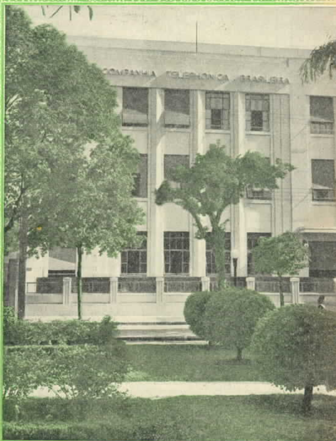
PRÉDIO DA NOVA ESTAÇÃO AUTOMÁTICA DE NITERÓI
