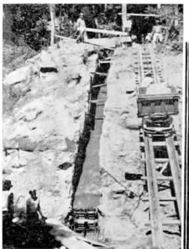
Rua Jussara, no "Jardim Laranjeiras", vendo-se a construção de uma caixa subterrânea o 3.º lance de dutos galgando a rampa.
