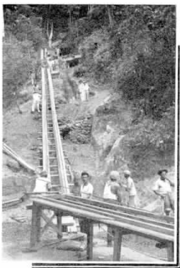
Vista apanhada além da escadaria da rua Marechal Francisco Moura, vendo-se a construção do 14.º lance de dutos armados no interior do parque além daquela rua.
