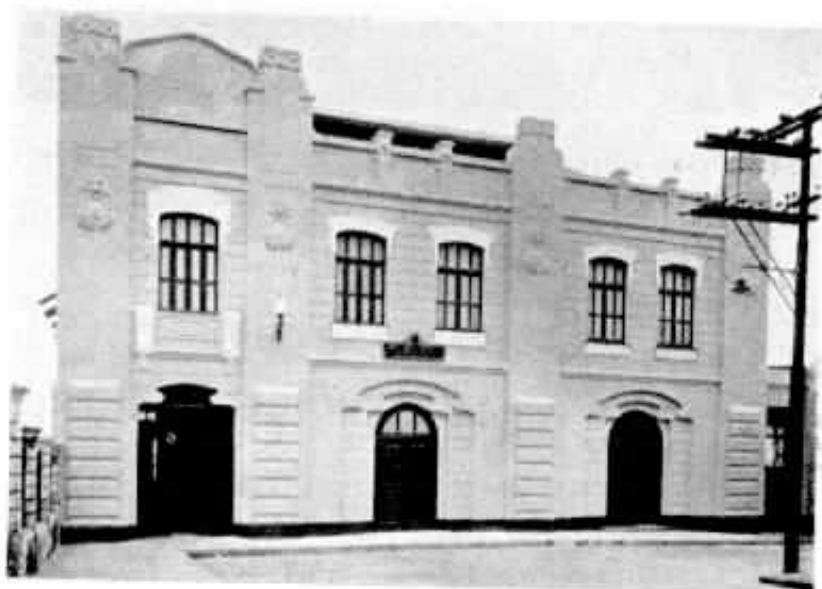
Vista da fachada da estação telefônica automática "Central", em Salvador, Estado da Baía.
